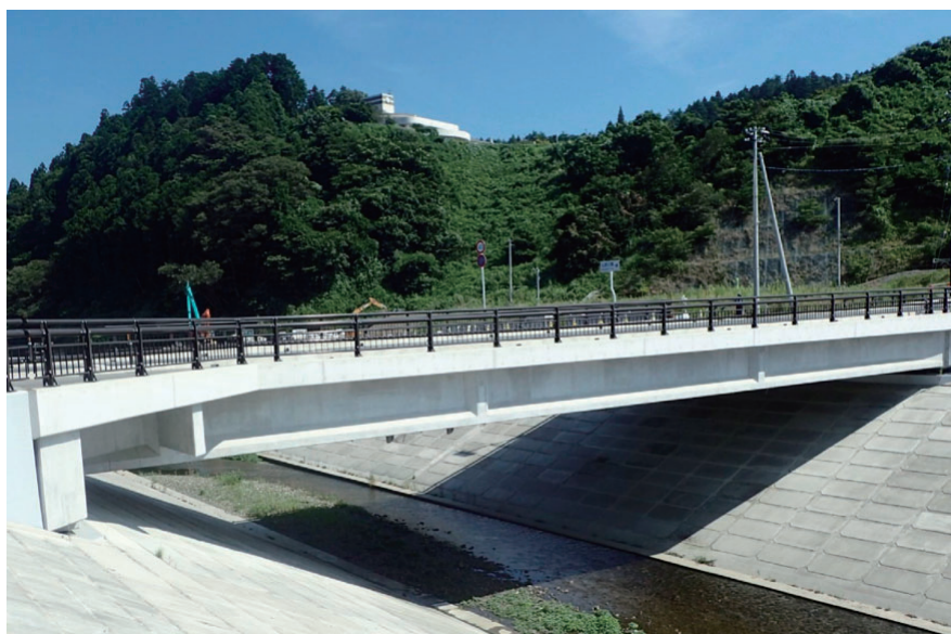
橋梁写真（志中大橋）
