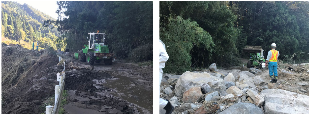
直轄代行による啓開作業状況（国道 349 号）10 月 14 日～ 18 日
