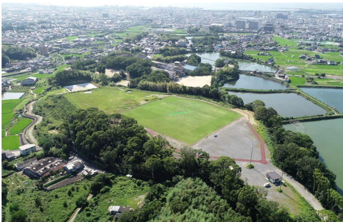
写真-3 ドローンによる現場上空からの写真
