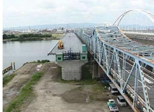
【写真⑦】手延式送出し工法 施工状況
