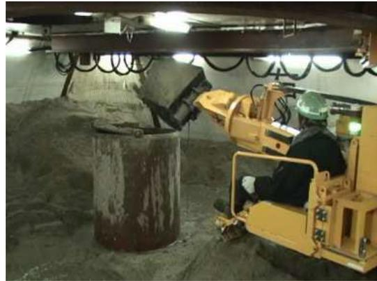
【写真⑥】 ニューマチックケーソン工施工状況
