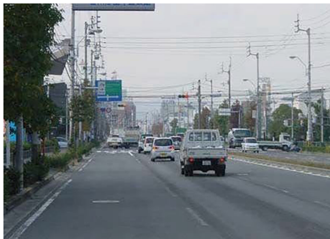
【事例② 標識の乱立による視認性が阻害】
