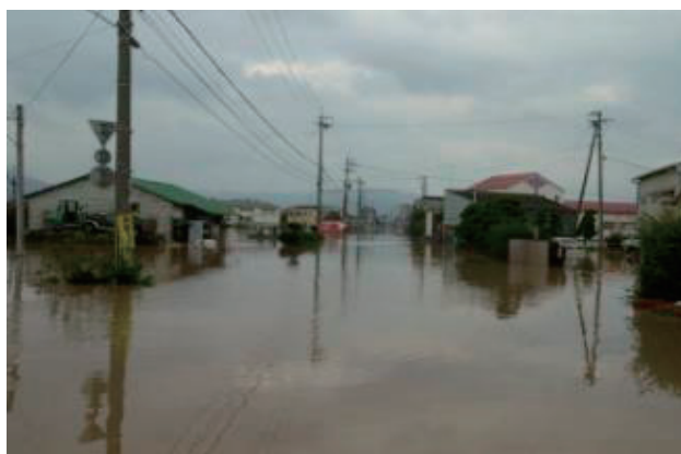
写真①:水没した国道312号(豊岡市日高町東芝地内) 撮影日:平成16年10月21日
