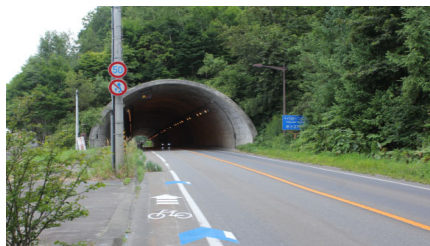
図 走行環境の安全性確保のための矢羽根型路面表示・注意喚起看板の設置
