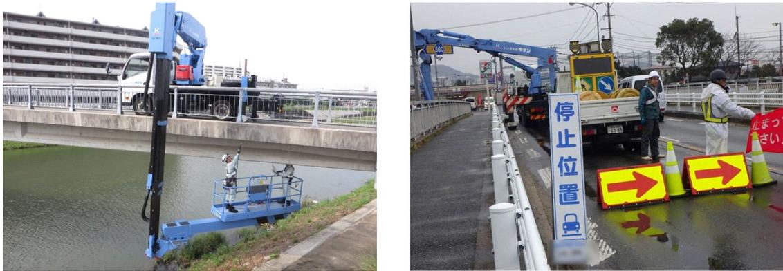
写真-1 橋梁点検車を用いた点検状況（右が交通規制状況）
