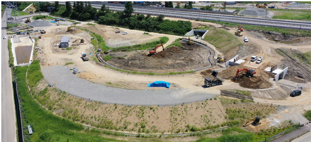
盛土工及びカルバート工②（令和2年8月20日撮影）
