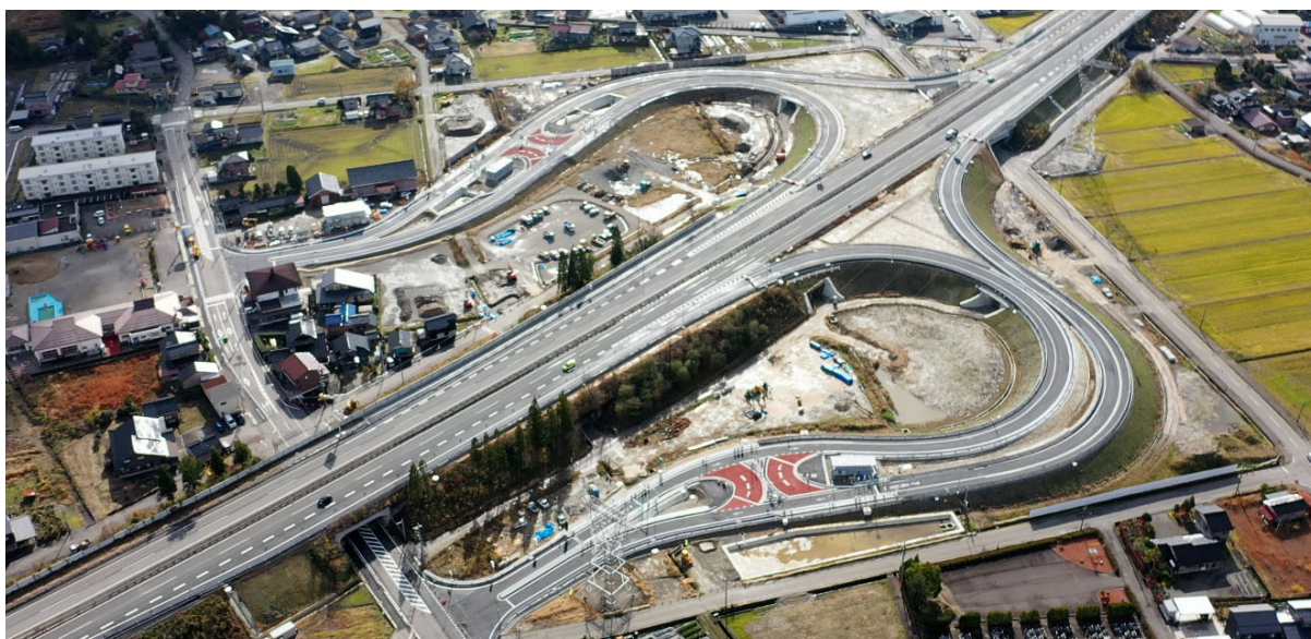
完成（令和2年12月4日撮影）
