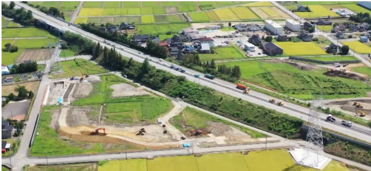
工事着工直後（令和元年 11 月頃撮影）
