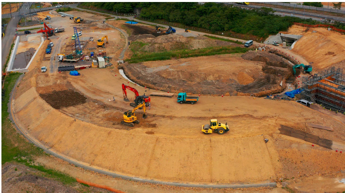
盛土工及びカルバート工①（令和 2 年 6 月 8 日撮影）
