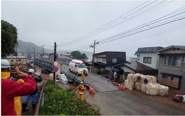
(仮橋設置により緊急車両通行可能)
