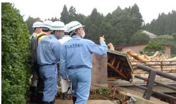
(小赤川橋 現況調査)
