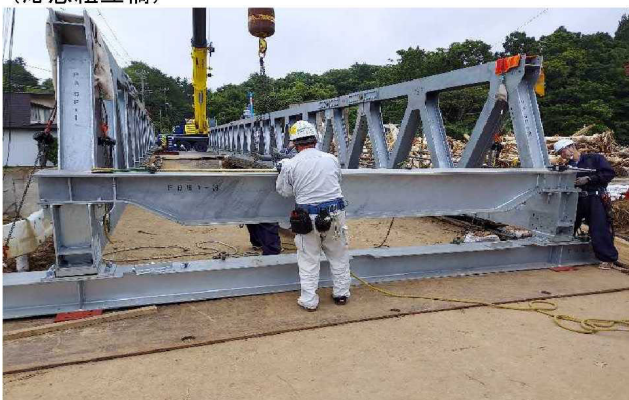
（応急組立橋 架設）
