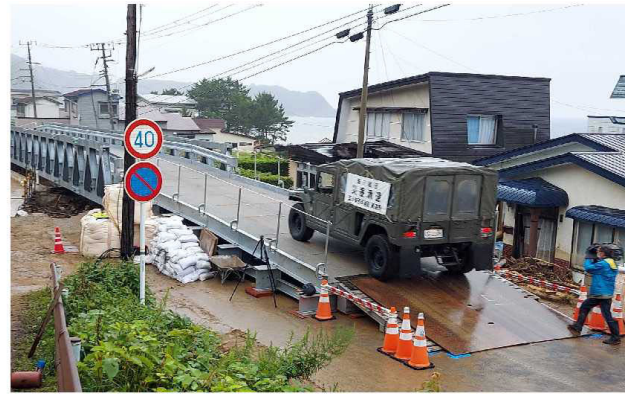
(仮橋設置により緊急車両通行可能)
