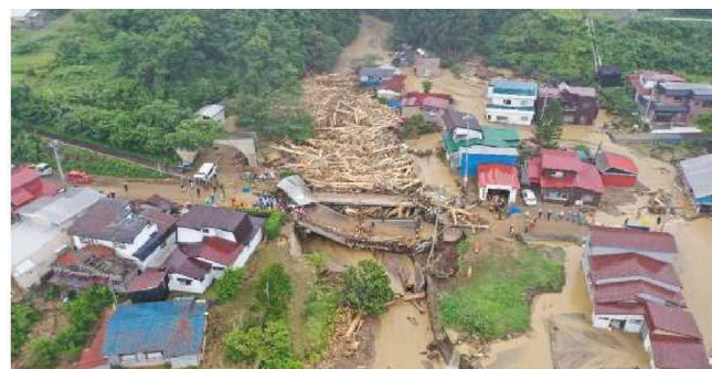
(R279小赤川橋 被災状況)
