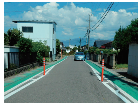
仮設の狭さく施設設置の様子
