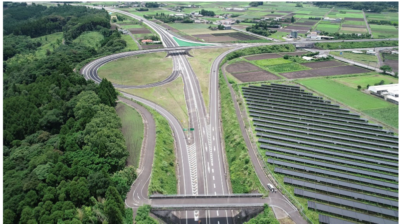
写真-1 鹿屋申良ジャンクション
