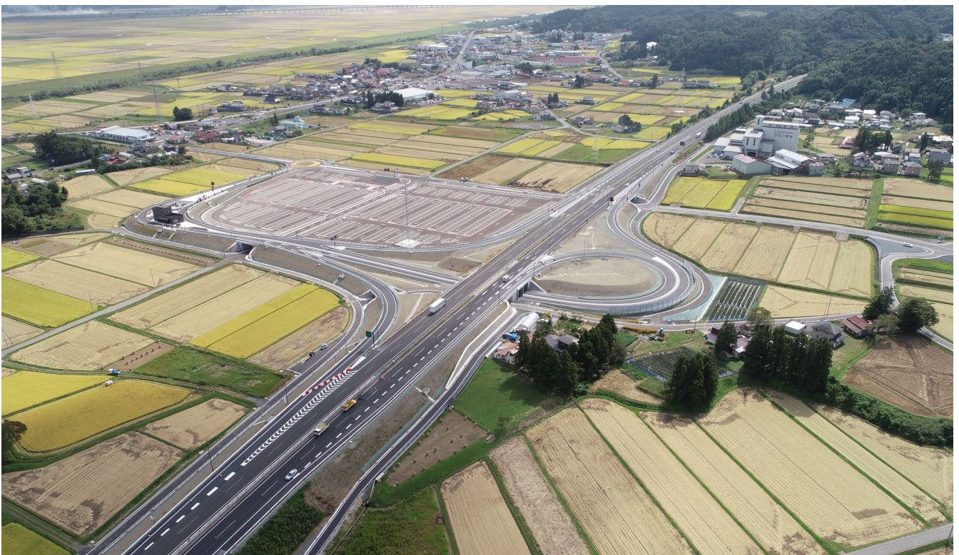
【完成状況（令和 3 年 9 月 28 日撮影）】
