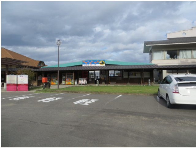
写真-3 バーベキューハウス
