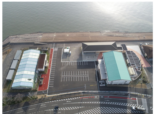
写真-9 令和3年度駐車場工事 (完成)
