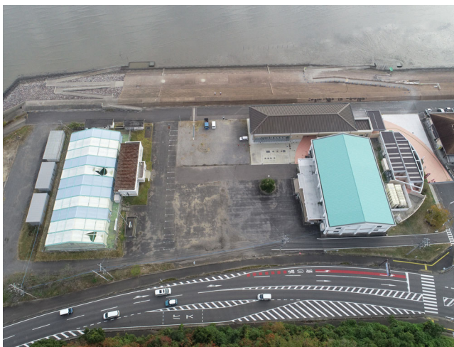
写真-8 令和3年度駐車場工事 (着工前)
