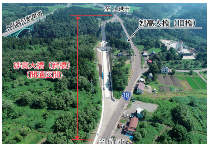
開通した妙高大橋（開通区間全景）
