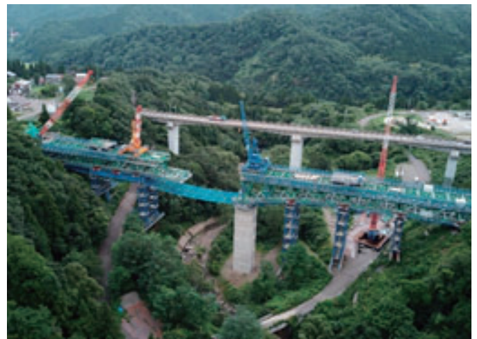
R2.8 トラス桁架設状況
