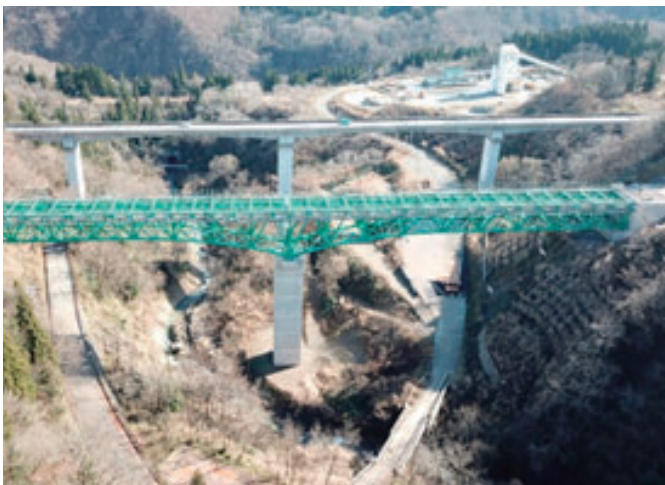
R2.11 トラス桁架設完了
