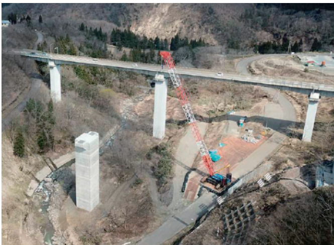
R2.4 橋台・橋脚施工完了
