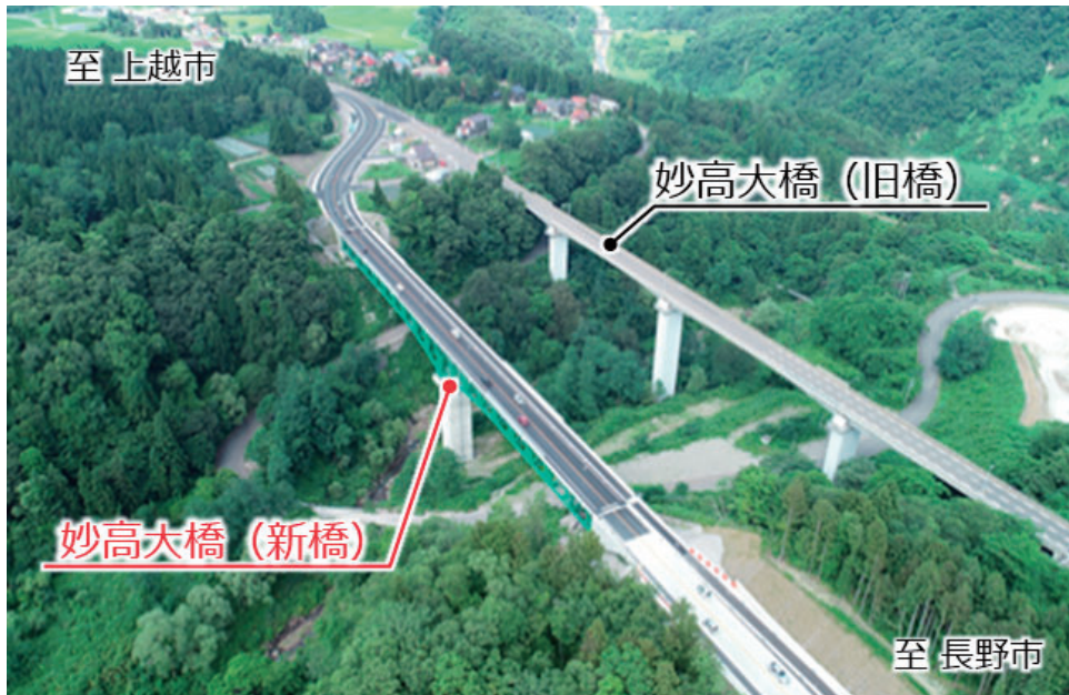
開通した妙高大橋（橋梁全景）
