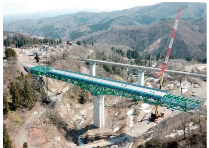
R3.4 合成床版架設状況
