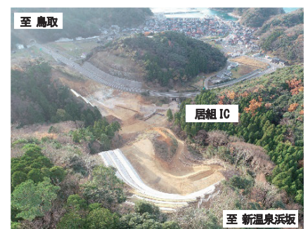
【居組IC改良工事】
