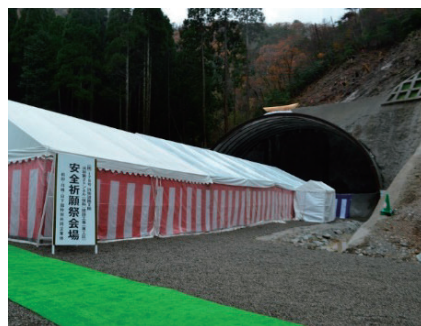
【浜坂第2トンネル工事 (東工区)】
