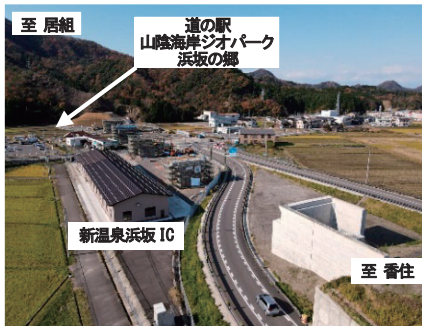
【浜谷高架橋下部工事】
