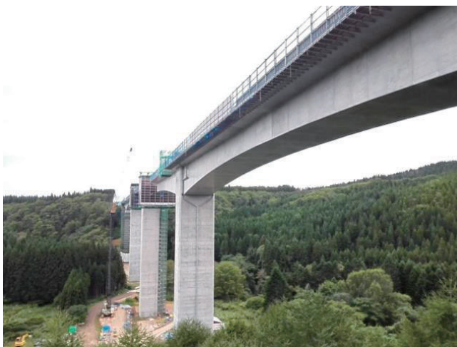
写真3 別当大橋の施工状況
