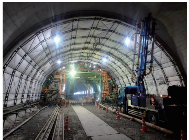
写真4 渡島丸山トンネルの施工状況
