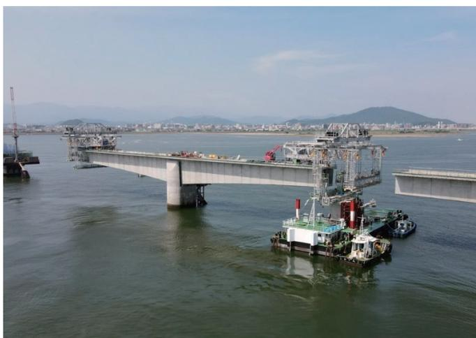
写真－3 上部工の施工状況（エレクションノーズ架設）
