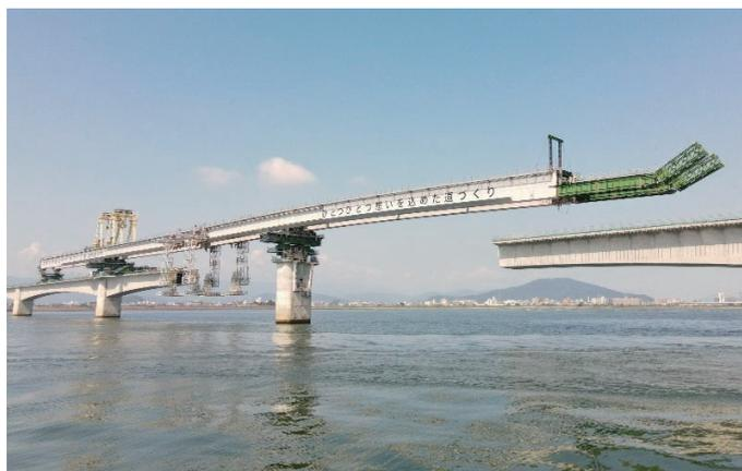
写真－4 上部工の施工状況（架設桁架設）
