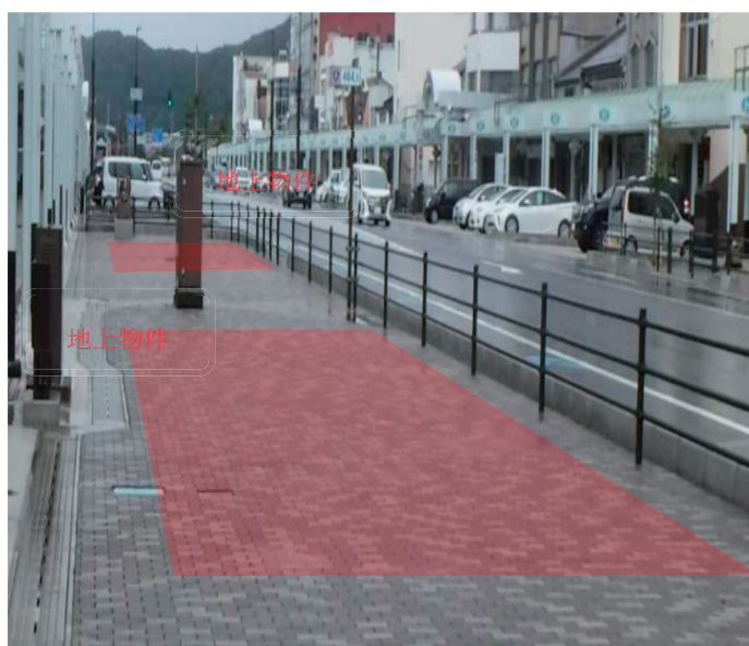
写真-3 地上物件との離隔を考慮した誘導区域
