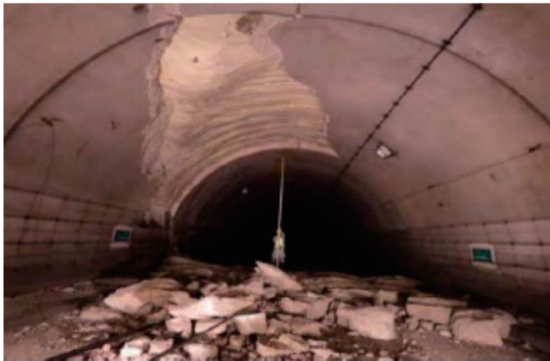
俵山トンネル覆工コンクリートの崩落
