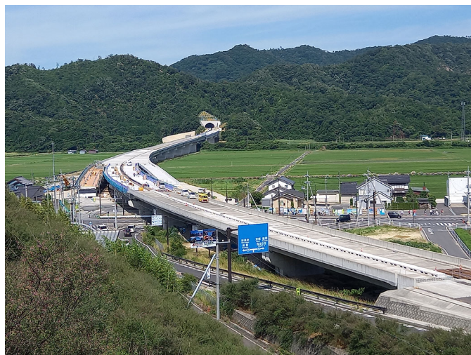
写真－2 浦富ICと浦富高架橋の様子
