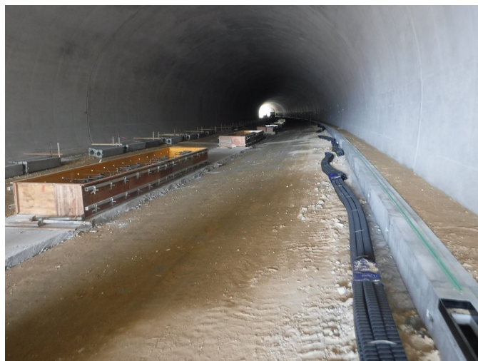
写真－4 牧谷トンネルの様子
