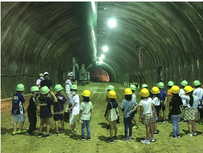
写真-8 小学生の現地見学会の様子
