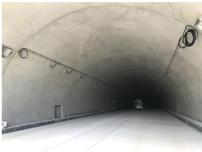
写真－3 東浜トンネルの様子
