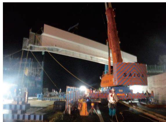
写真-6 前田第一跨道橋架設状況
