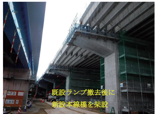
写真-4 新設本線橋の架設完了状況
