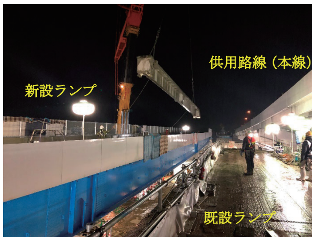
写真-3 有田南 IC 既設オンランプ橋撤去状況
