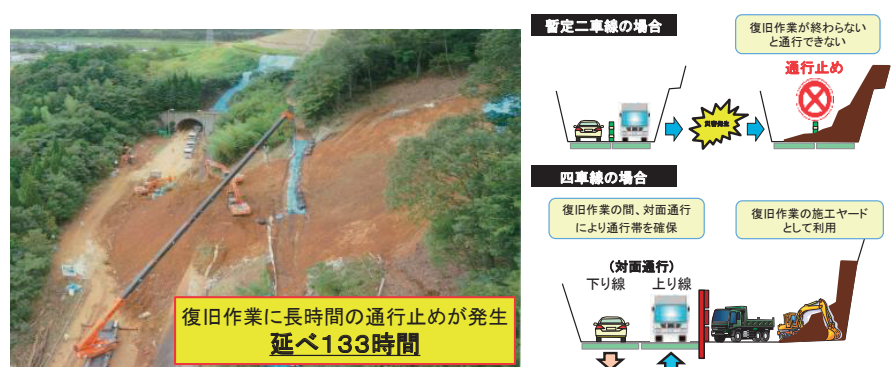
図-4 道路機能の強化(道路啓開)
