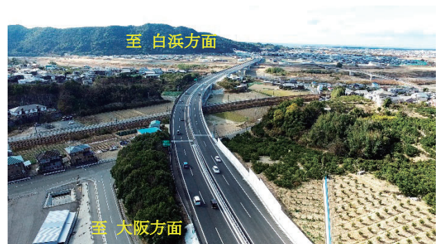
写真-2 御坊 IC 付近完成状況
