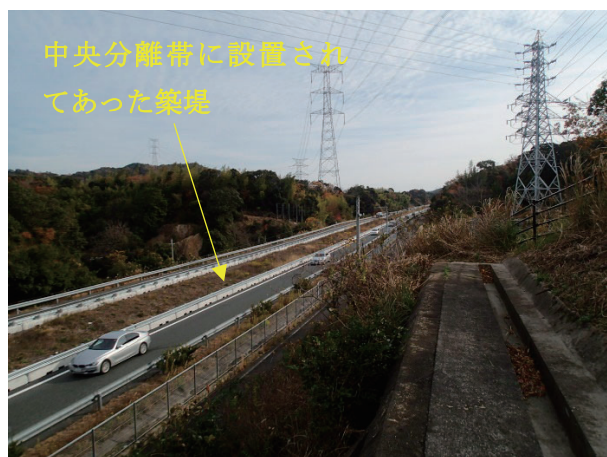
写真-8 築堤撤去前
