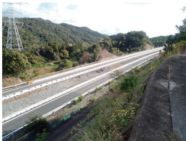
写真-9 築堤撤去完了
