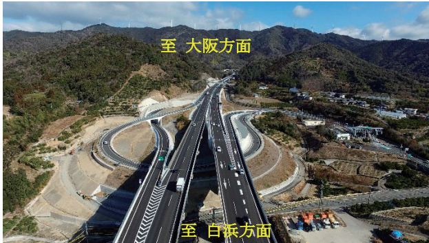
写真-1 川辺 IC 完成状況
