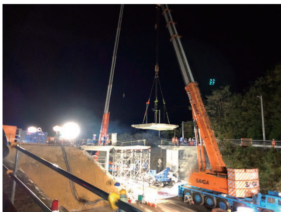
写真-5 前田第一跨道橋撤去状況
