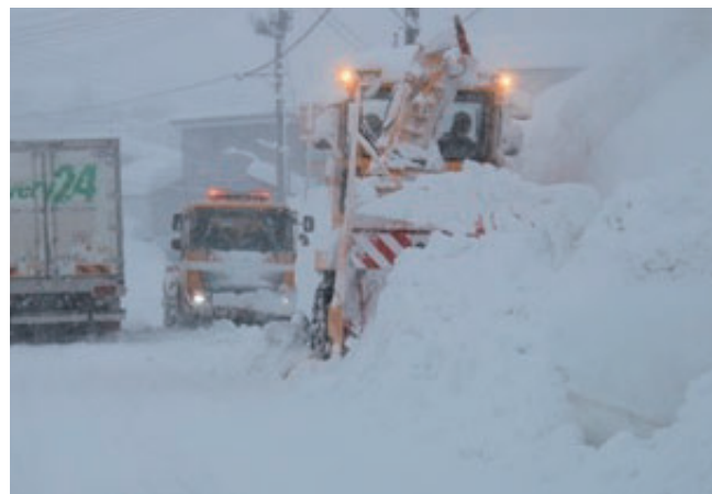
ロータリ車による懸命な除雪作業（妙高市内）
