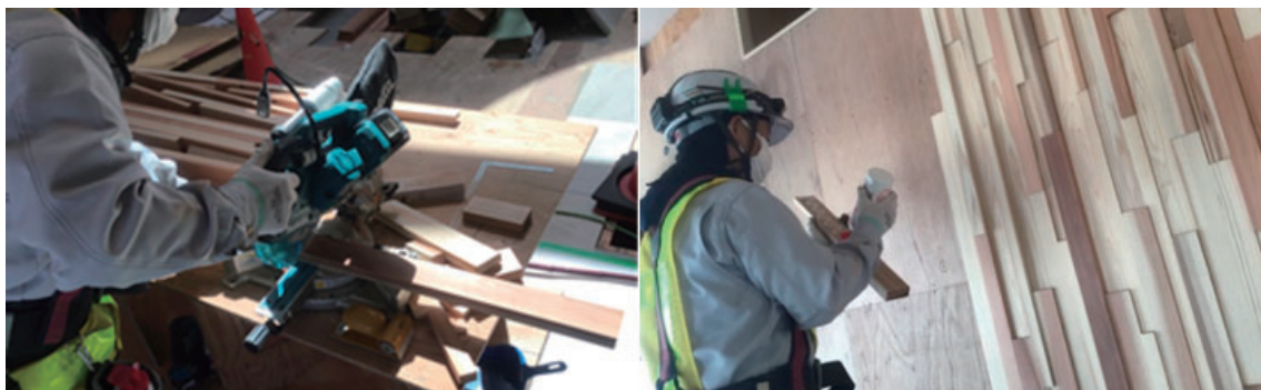
写真－4 木レンガ施工状況
