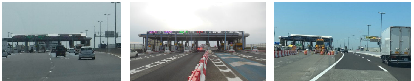
写真－1 泉大津本線料金所撤去状況（左：工事着手前／中：固定規制時／右：本線料金所機能停止後）
