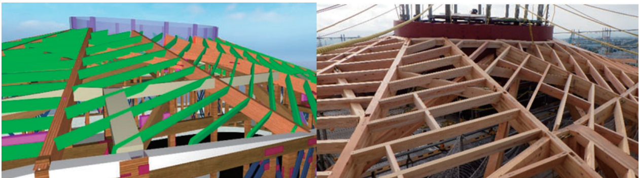
図－5 BIMモデルと現場比較
