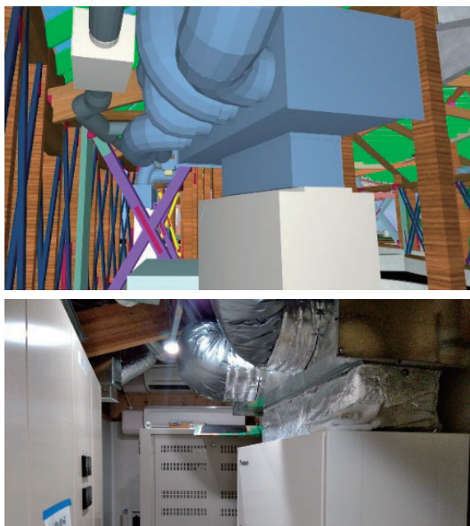
図－6 空調機納まり検討図と現場比較
