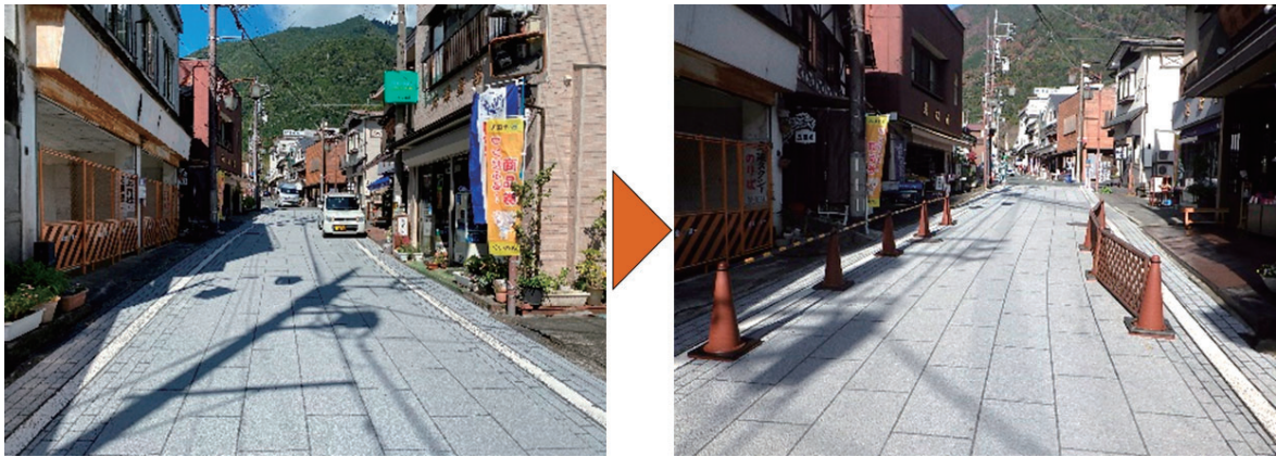
写真－6 狭さくの施工前と施工後
