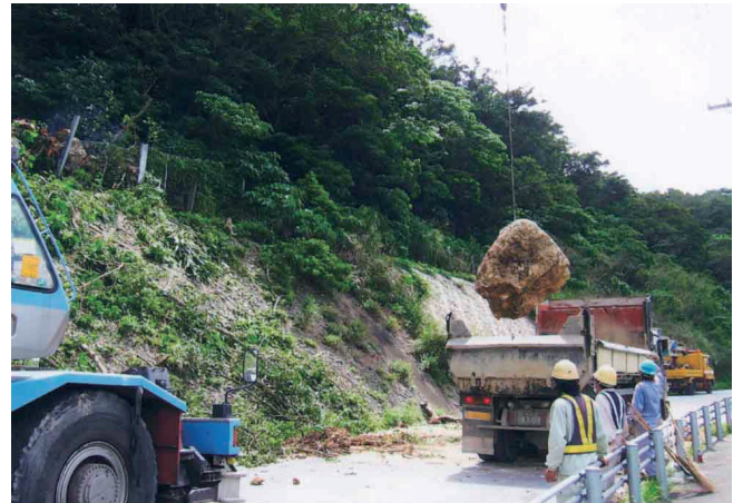
写真－2 県道南風原知念線災害復旧状況
