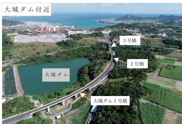
写真-6 区間 3 (大城ダム 1 号橋 ,2 号橋, 3 号橋) 付近現況
