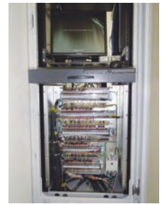
中央制御装置
