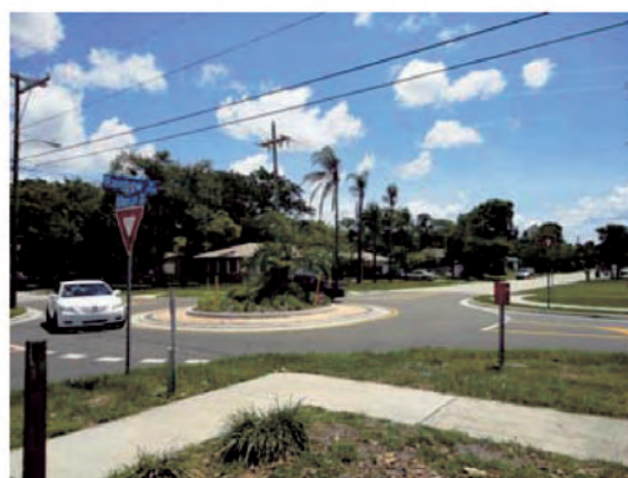
図6 住宅地におけるコンパクト・ラウンドアバウトの例 (米国・フロリダ州)
