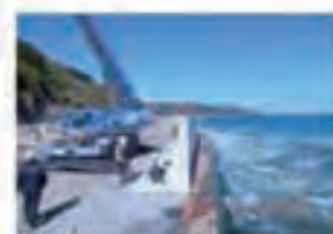
河川の緊急復旧（石巻市、北上川） 東北地方整備局調べ
