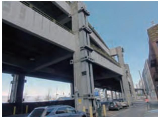
写真6・7 Nisqually 地震により被災した橋脚の例
