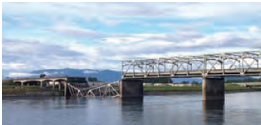
写真 1 落橋した I - 5 Skagit County Washington 州
