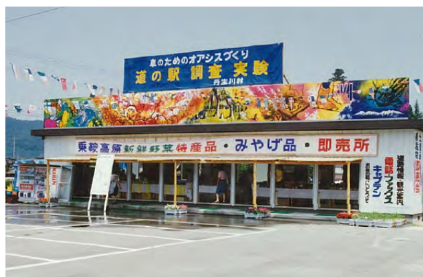
写真1 岐阜県：道の駅「丹生川村」
