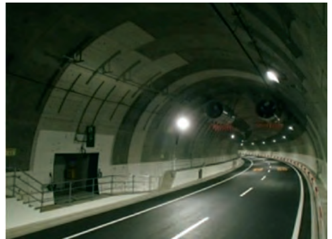
写真1 中央環状線（シールドトンネル内）
