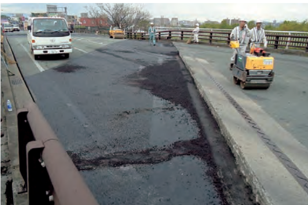
写真9 復旧状況 (国道3号 松崎跨線橋)
