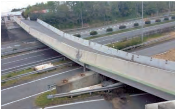
写真1 府領跨道橋の落橋(九州道)
