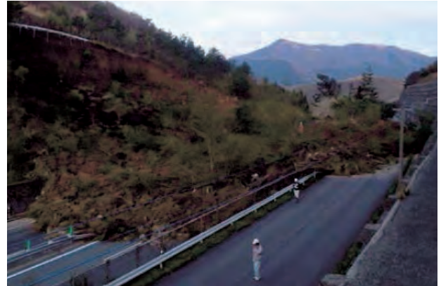
写真2 切土法面の崩落(大分道)
