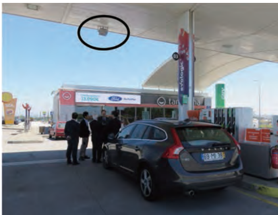
車載器との通信用のアンテナ
