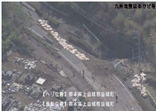
写真12 被災状況の把握（国道443号）
