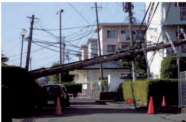
写真6 電柱の倒壊(町道 熊本県益城町内)
