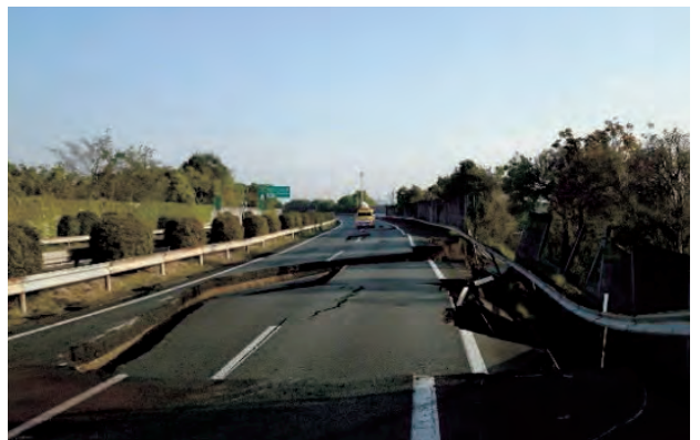
写真8 復旧状況(九州道)
