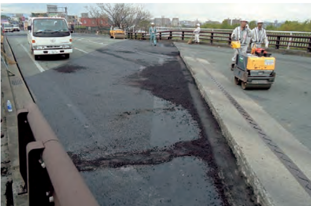
写真9 復旧状況 (国道3号 松崎跨線橋)
