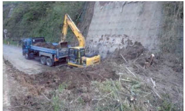
写真10 復旧状況 (グリーンロード南阿蘇)
