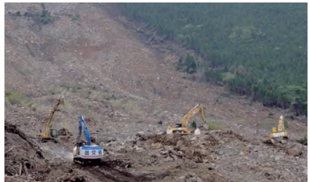
写真11 無人機械を用いた不安定土砂の撤去作業
