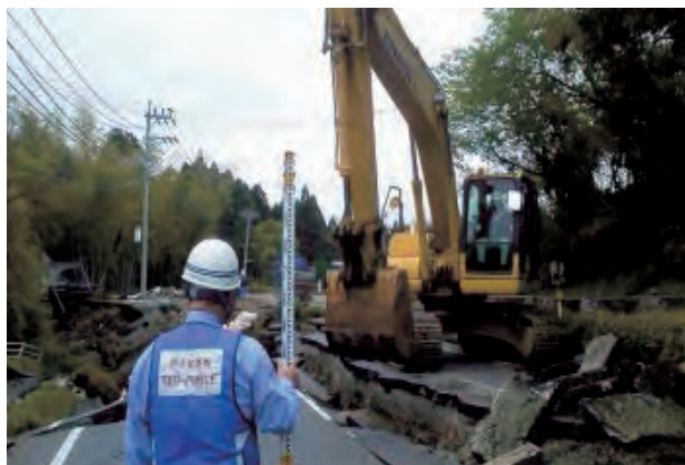
写真13 応急復旧（道路啓開）（国道443号）
