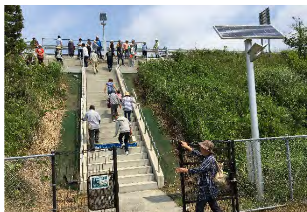
写真6 新設した避難階段での避難訓練 (東松島市)
