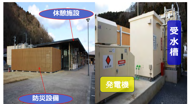
写真10 防災機能の強化(受水槽、発電機等)を進めている事例 (道の駅「上品の郷」【宮城県石巻市】)
