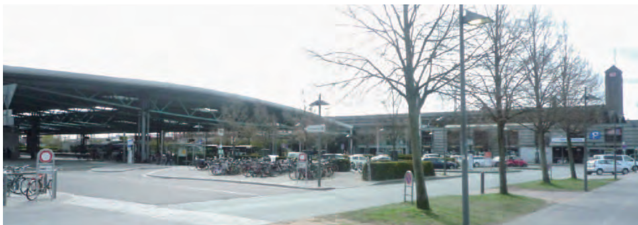
図8 オルデンプルク駅前。交通結節点として、無料の駐輪スペース、有料の自転車駐車場（青字のPのマークの建物）、バスターミナル（大屋根の下）などが整備されている。
