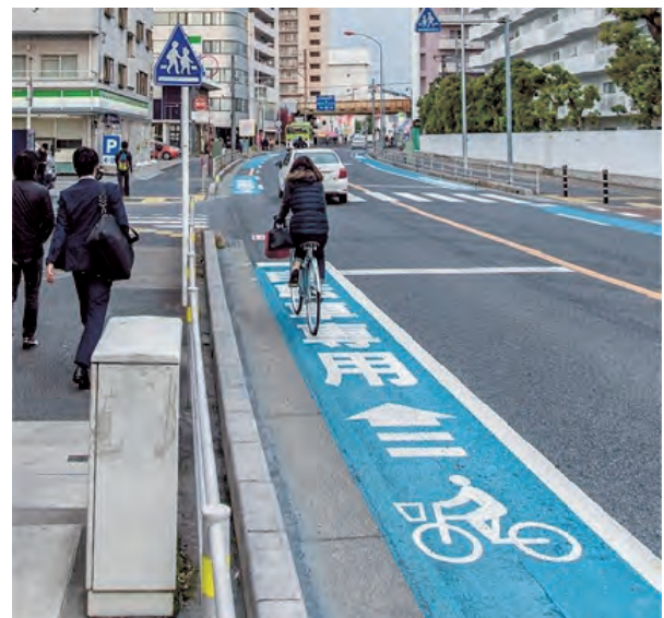
写真4 矢羽根・ピクトグラムが整備された自転車専用通行帯（国道17号・さいたま市）
