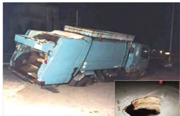
下水道の老朽化による道路陥没
