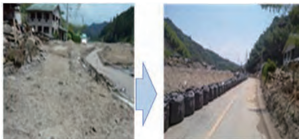
災害時の道路啓開
