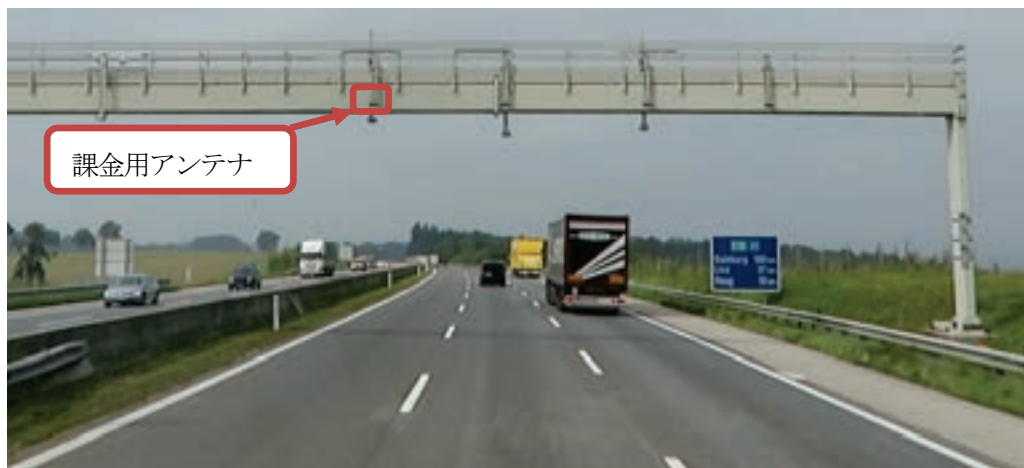
図3 課金用アンテナだけのガントリー
