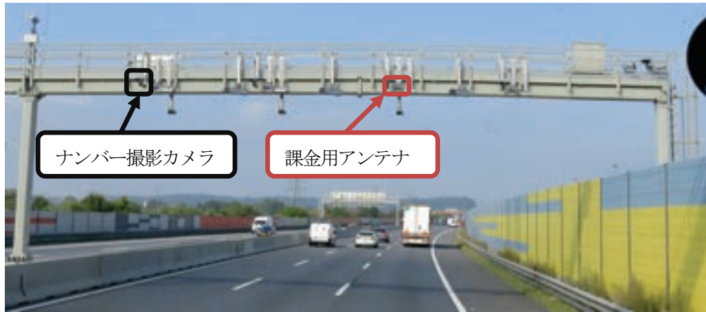
図4 エンフォースメント用のカメラも設置されたガントリー
