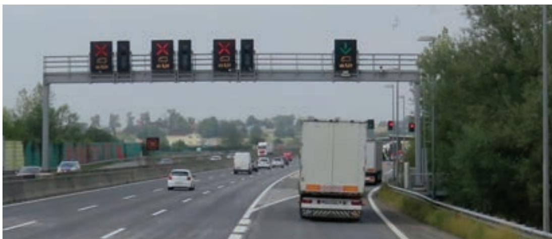
図5 3.5t以上車両の指示 表示板で右車線に入るように指示 指示通りに右側車線を走行すると大型車両重量検査施設に進入
