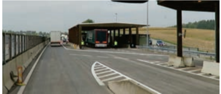
図7 軸重が重い車両は右側の建物へ
