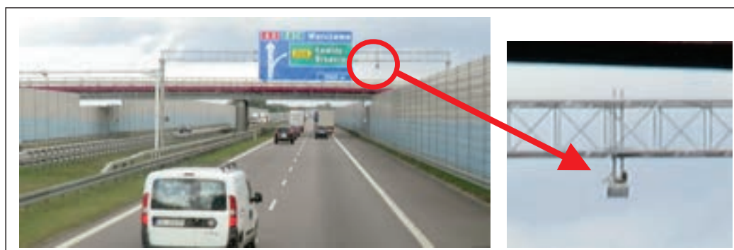
写真8 既設の設備を利用してアンテナを設置
