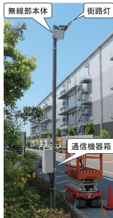
図4 民間向け簡易型路側機無線部の設置例
