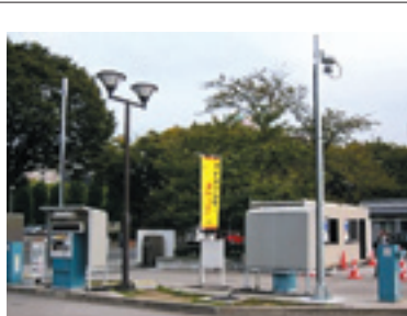
名城公園駐車場におけるDSRCアンテナ
