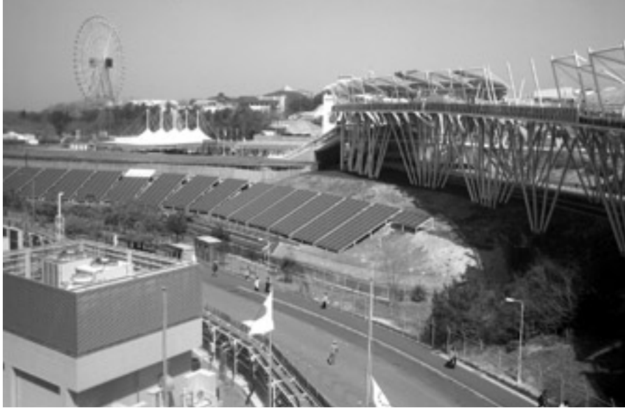
長久手会場・西ゲート前の斜面に設置された多結晶シリコン太陽電池、右はグローバル・ループのフェンスに設置された単結晶シリコン太陽電池。左はNEDOパビリオンの新エネルギープラント。
