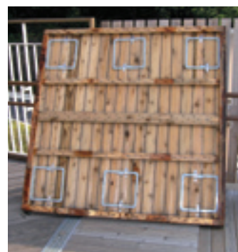
■ 瀬戸会場内連絡橋の床下に 設置した RF-ID タグ
