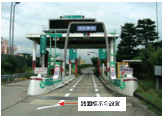
料金所における路面標示の設置
