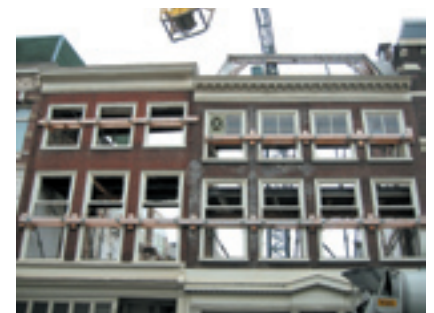
改装工事の様子
