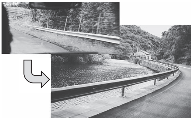
ガードレールの塗装 (白⇒緑へ)
