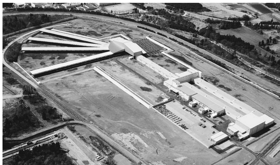
衝突実験場(日本自動車研究所)
