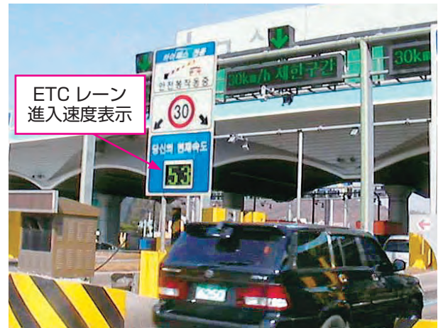
図3 ETCレーン進入速度表示
